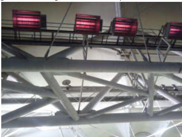
Heizstrahler in ca. 5-6m Höhe
